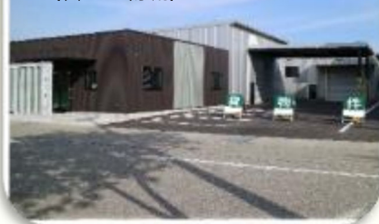
小松市小松工業団地工場倉庫 (株)CTC物流
